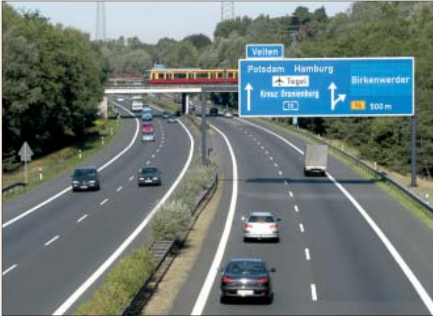
▲ Beschilderung an der Anschlussstelle Birkenwerder auf der A10. Foto: R.J.Fischer
